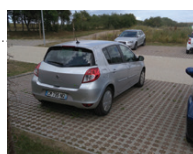
Structure béton alvéolaire
