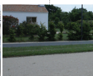
Revêtement en calcaire sablé
