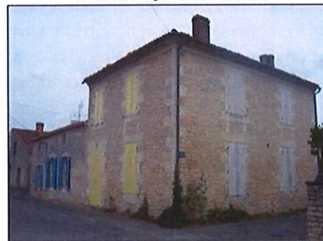
Maison de bourg dans le hameau de Souhe
