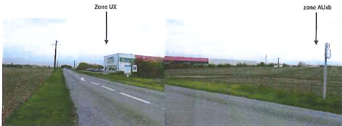
Vue depuis la RD 131, en direction de la frange ouest de la ZA commerciale
