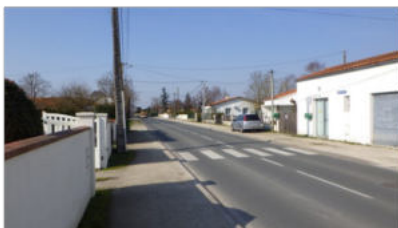
Tissu bas et discontinu rue S. Champlain-RD31, "tenu" par les murets et quelques façades bâties
