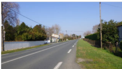
Profil routier et urbanisation diffuse le long de la RD733
