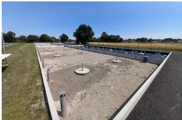
La station d'épuration de Saint-Saturnin-du-Bois permet de traiter les eaux usées de 800 E.H (Équivalents-Habitants).
