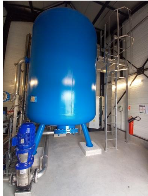
Ballon du filtre à charbon actif du dispositif de traitement des pesticides
