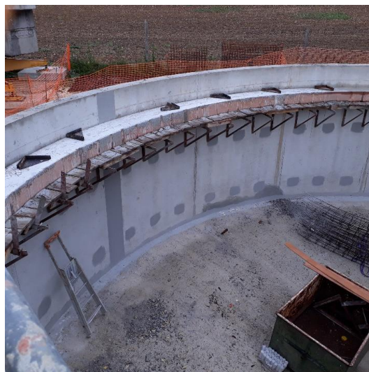
Coulage de la goulotte du clarificateur
