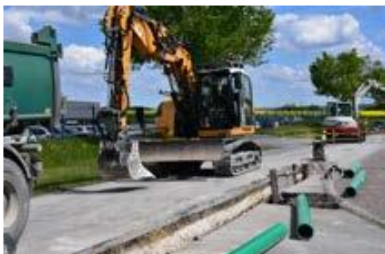
Pose des conduites d'assainissement
