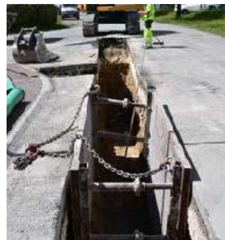
Tranchée commune pour la pose du réseau d'assainissement collectif et le renouvellement du réseau d'eau potable
