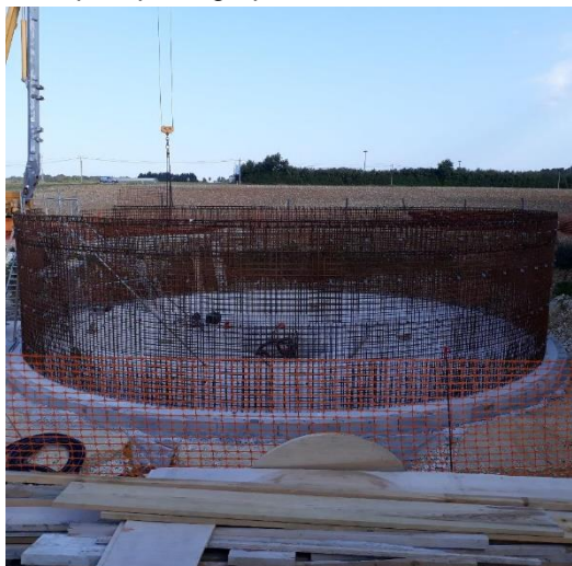
Ferraillage du clarificateur
